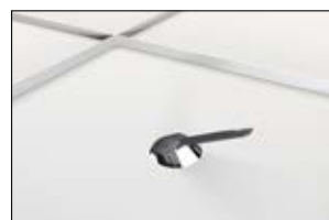
1. Włóż rozpórkę w otwór montażowy.
