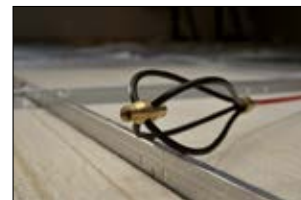
Trzepaczka ułatwia przeciąganie przewodu po nierównej powierzchni.
