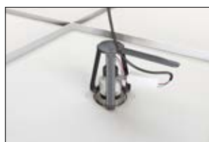
4. Podłącz zasilacz i wsuń przewód w uchwyt kołpaka.
