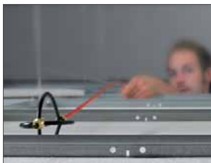
Trzepaczka ułatwia przeciąganie przewodu po nierównej powierzchni.
